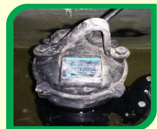
EFFLUENT PUMP & JET AERATOR
